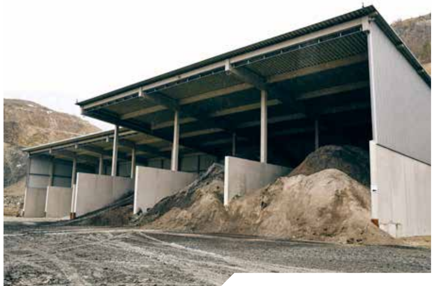
5.500 m 3 Lagerkapazität direkt bei der Bruchsteinproduktion im Steinbruch Micheldorf: Die neu errichtete Lagerhalle erfüllt behördliche Vorgaben und steigert die Effizienz der Stoffkreisläufe, die im nahegelegenen Kirchdorfer Zementwerk zusammenlaufen.
