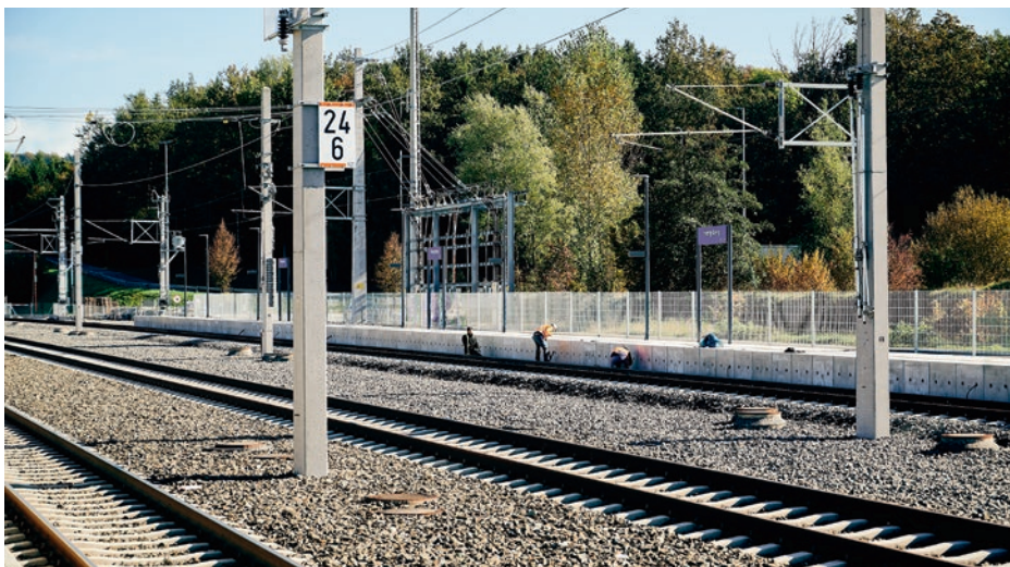
Nicht nur Sonderprodukte: Neben den komplexen und spektakulären Tübbing- und Gleistragplatten-Produktionen liefert die Kirchdorfer Gruppe entlang der Strecke auch wieder viele „Standardprodukte“ wie Bahnschwellen, Weichenschwellen, Fahrleistungsmasten und Bahnsteigkanten, wie sie hier gerade am Bahnhof Hengsberg installiert wurden.
