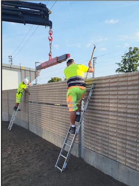
Installation der Teststrecke der Schallschutzwand im niederösterreichischen Kottingbrunn. C Kirchdorfer
