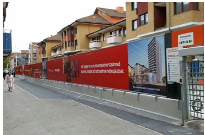
DELTABLOC® everywhere: Die omnipräsenten Betonschutzwände sind neuerdings sogar mitten in der Fußgänger- und Radfahrzone zu bewundern. Inklusive eleganter Werbeaufbauten.
