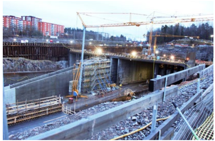
E4 Stockholm Bypass: Die 3 Mrd. Dollar teure Umfahrung ist eines der größten und komplexesten Bauvorhaben aller Zeiten. Ein 16,5 km langer Tunnel wird in einer Tiefe von 100 m unter den Mälaren-See geführt.
