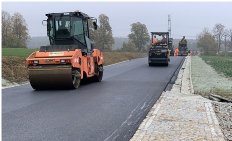
Öffentliche Straße, privat errichtet: Mit der 2 km langen Umfahrungsstraße trägt Kámen a písek zum Gemeinwohl und zur Erhöhung der Lebensqualität der Steinbruch-Anrainer bei.
