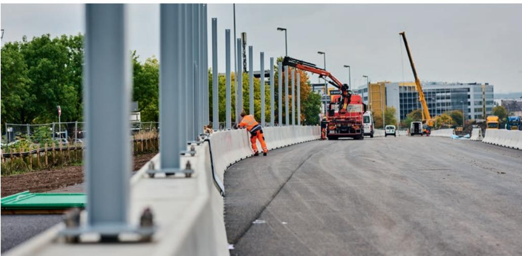
„Rundum-Sorglos-Paket“: Installation von Lärmschutz- und Rückhaltesystemen an der A81 bei Sindelfingen.
