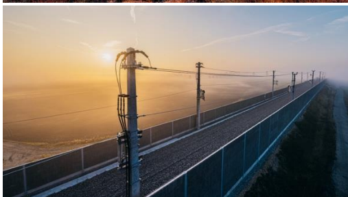
Bauarbeiten im Streckenabschnitt rund um den neuen Bahnhof Ebreichsdorf / Pottendorfer Linie.
