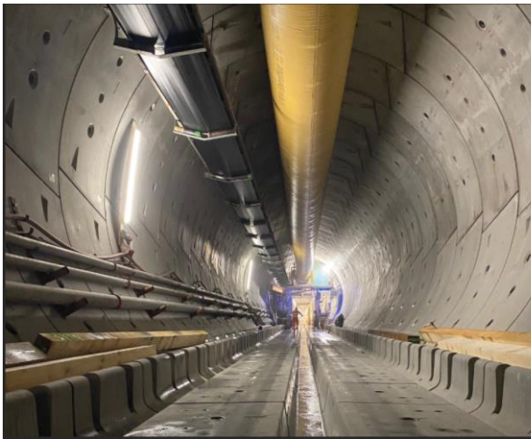
Die Tübbinge von Katzenberger versteifen Teile des Kerrenzerberg Tunnels in der Schweiz. Sie bilden eine stabile Außenschale für den Tunnel. © Kirchdorfer
