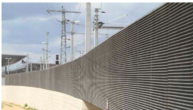
Bild: Zuverlässiger Lärmschutz für die Anwohner am neuen Hauptbahnhof Wien mit vollmineralischen PHONOBLOC DUO A3 Absorberplatten aus einer speziellen Leichtbetonmischung. Abdruck honorarfrei bei Nennung: MABA Fertigteilindustrie GmbH
