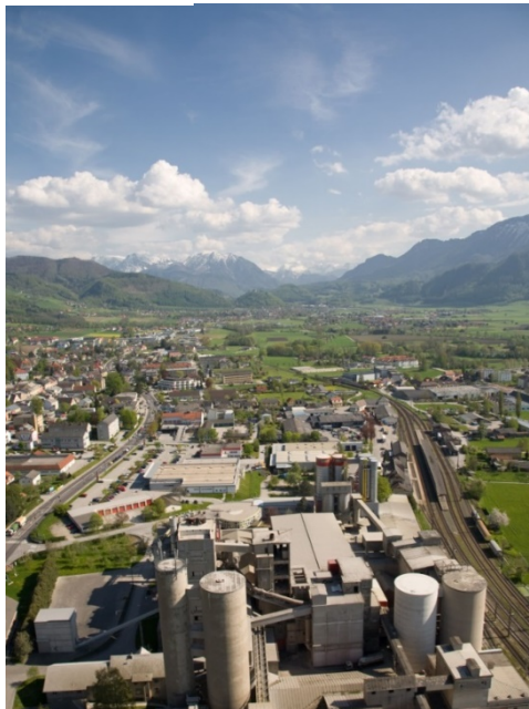
Luftaufnahme des Kirchdorfer Zementwerks
