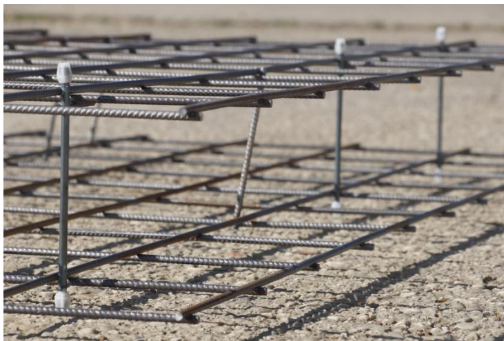
Bildlegende: Bewehrungskorb der neuen Maba-Korbwand
